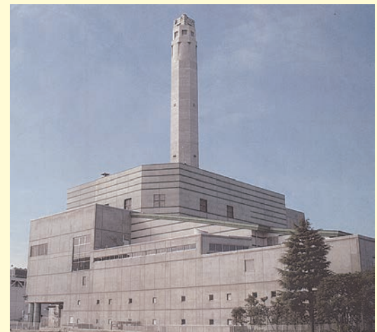
平成34年～40年度に北清掃工場の建替工事
