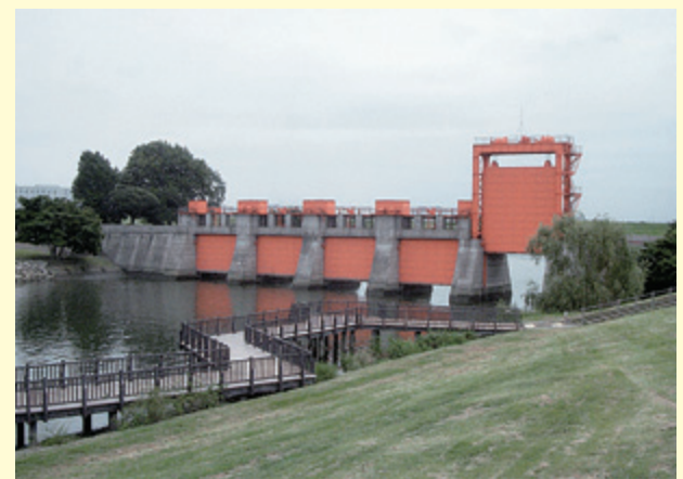
通称赤水門と呼ばれる旧岩淵水門
