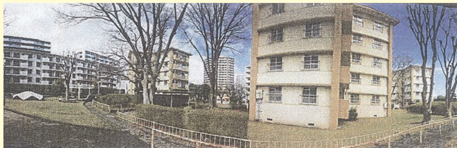
↑階段室型住棟（41号棟）
