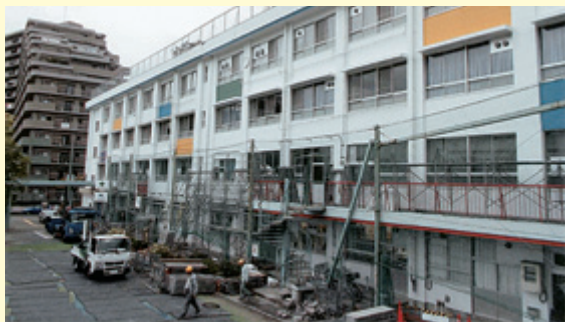
旧豊島北中学校の改修工事の様子
